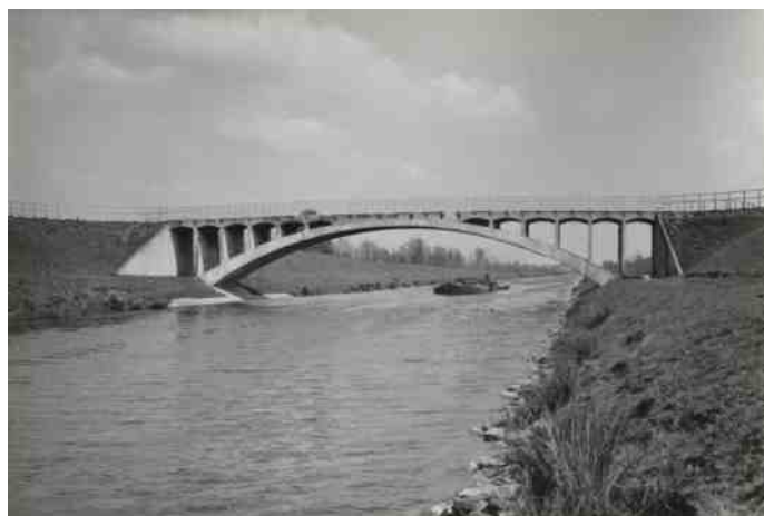
De eerste Laarbrug, een betonnen loopbrug
